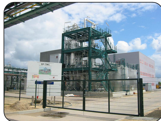
既存プラント
